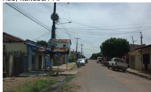
Foto 17 – Exemplos de ocupação de calçadas, e esgotamento sanitário lançado diretamente nas vias, Itaituba/PA.
