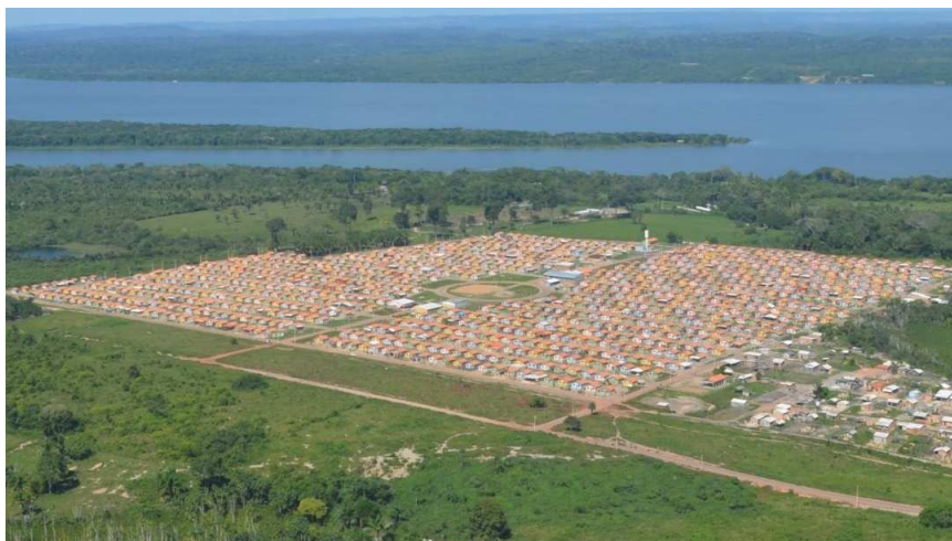
Foto 18: Vista aérea do primeiro conjunto “Minha Casa Minha Vida” implantado na cidade de Itaituba/PA, 2011.
