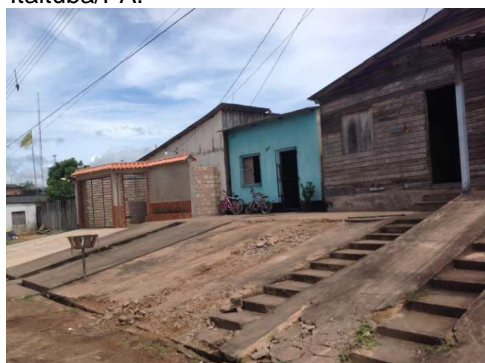
Foto 14 – Exemplos de residências que ocupam todo o lote, sem afastamentos laterais mínimos, Itaituba/PA.
