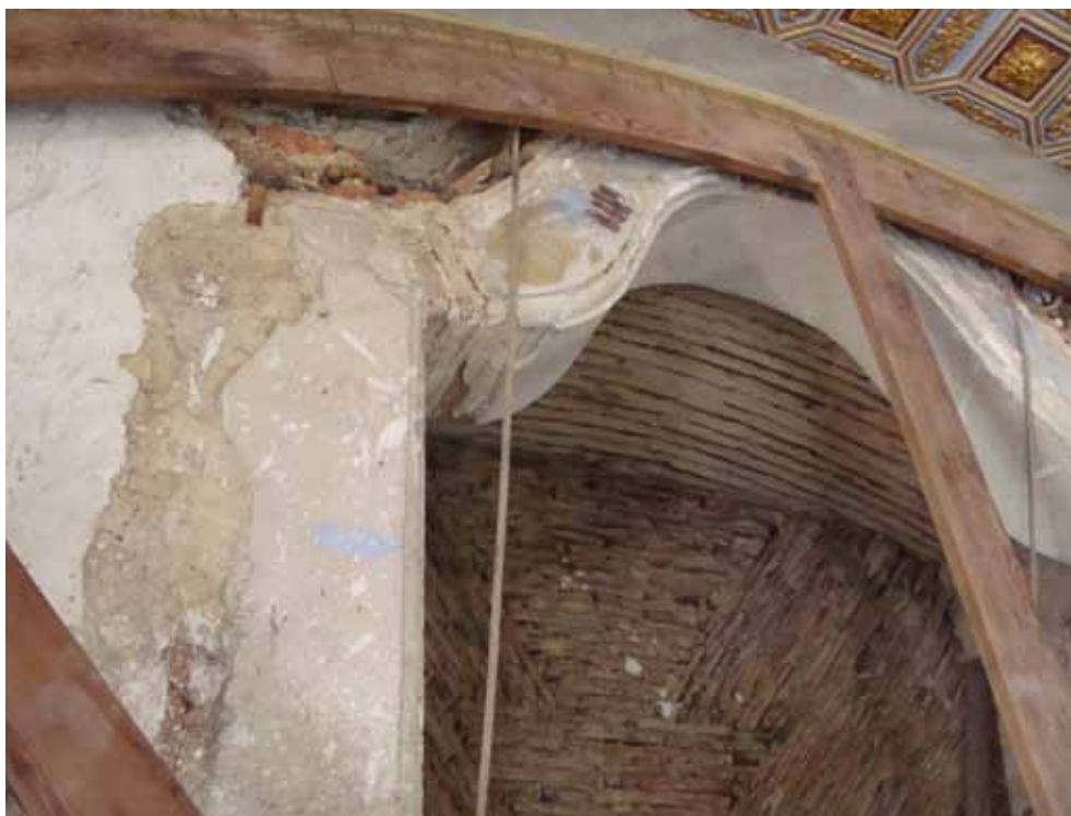
Figura 9 – Detalhe interno do nicho, no qual se percebe o desenho da tijoleira que compõe o seu fundo e sua abóbada. Fotografia de Jussara Derenji, 2009.
