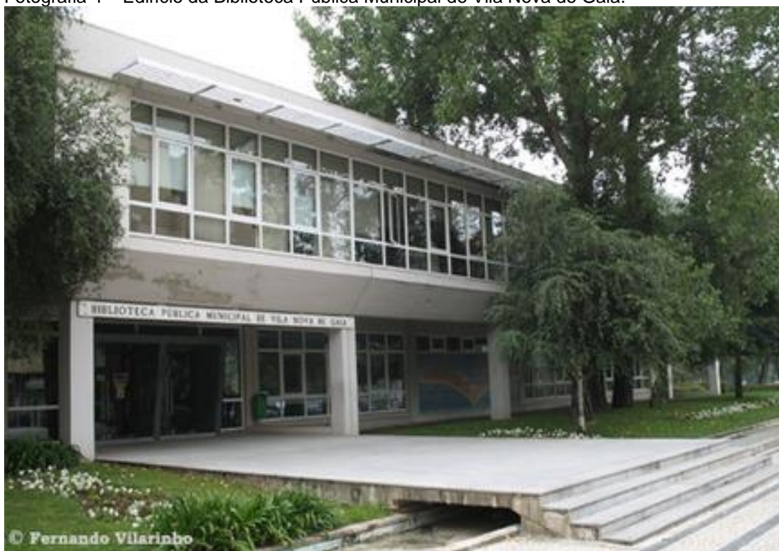
Fotografia 4 – Edifício da Biblioteca Pública Municipal de Vila Nova de Gaia.
