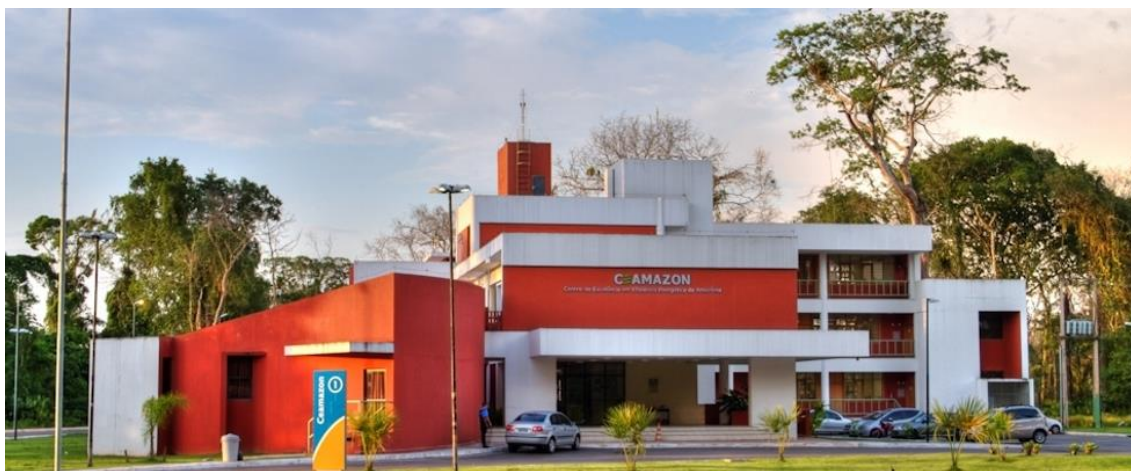
Figura 17 – Vista externa do prédio do Ceamazon
