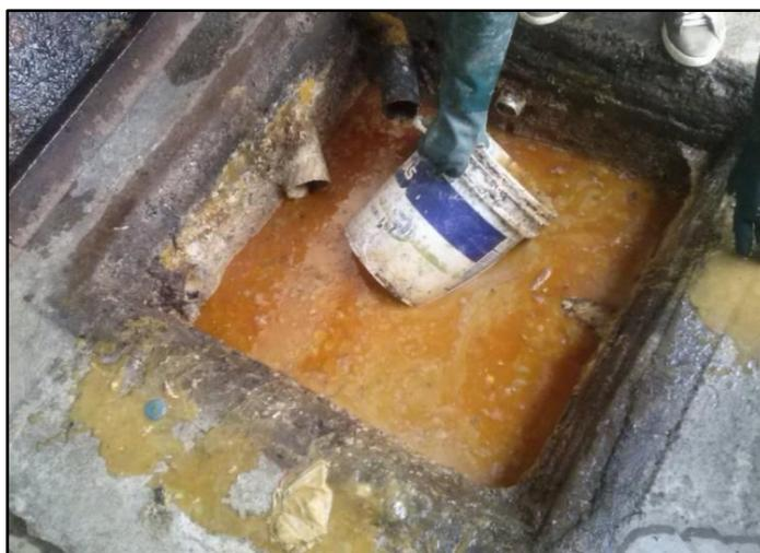
Figura 22 - Coleta do Material Residual das Caixas de Gordura do RU-UFPA.
