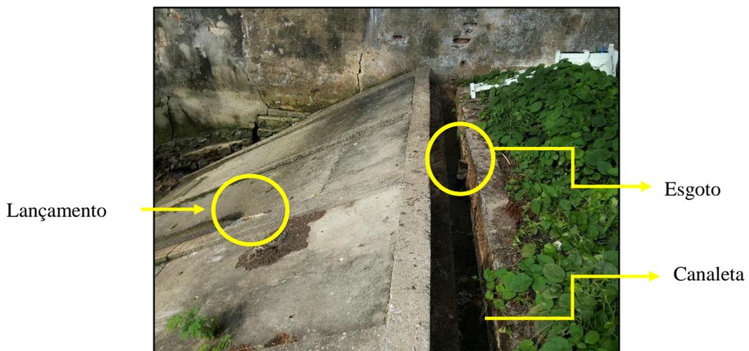
Figura 17 - Ponto de lançamento do efluente
