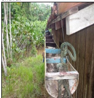
Foto 12 – Calha improvisada para captação da água da chuva.
