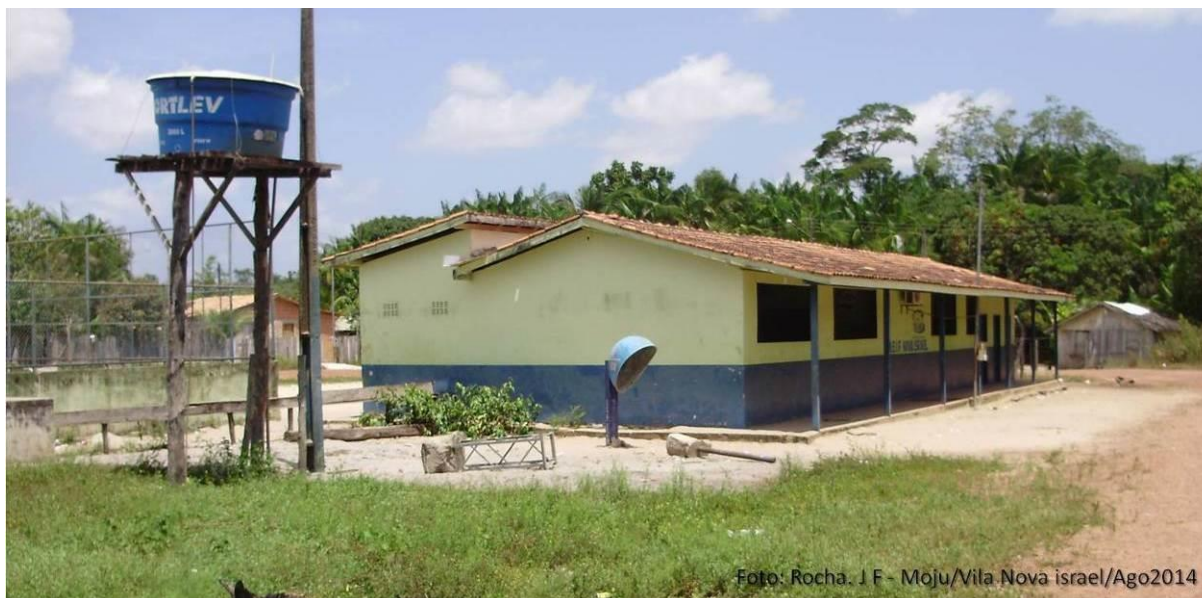
Figura 3 – A E.M.E.I.F. Nova Israel construída na comunidade é mantida pela Prefeitura de Tailândia.
