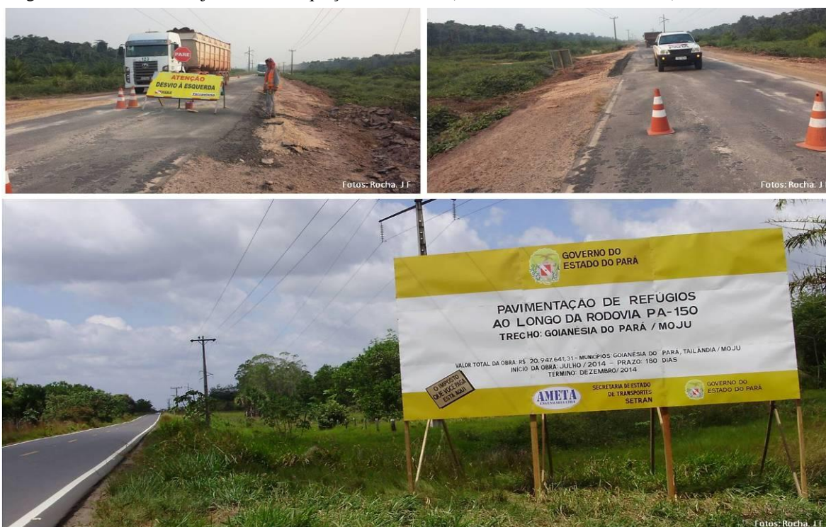
Figura 12 – Obras do Projeto de Readequação da PA-150 (Trecho de Tailândia PA-475) em 2013 e 2014.
