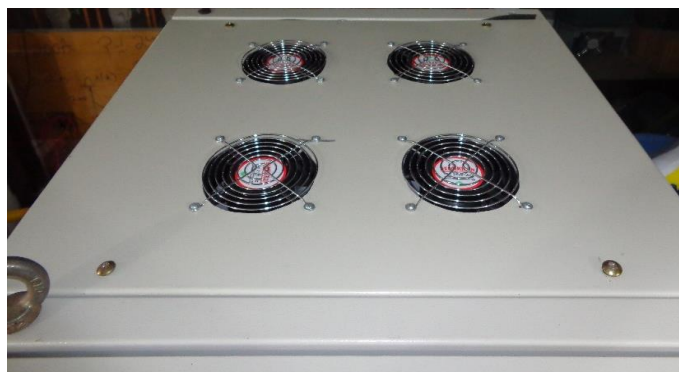
Figura 2.5 – Tampa superior do Painel. Montagem das Ventoinhas.
