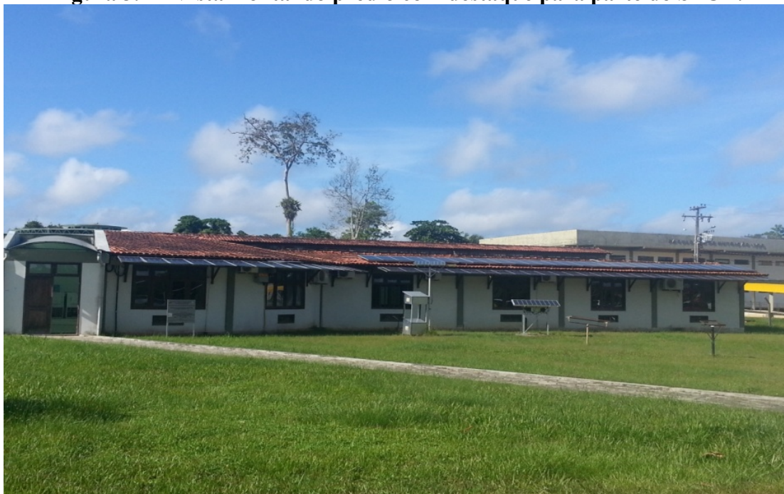
Figura 3.2 – Vista frontal do prédio com destaque para parte do SFCR.
