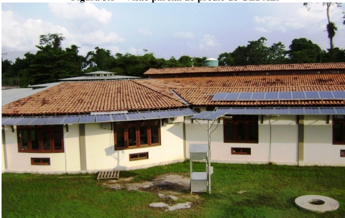
Figura 3.1 – Visão parcial do prédio do GEDAE.
