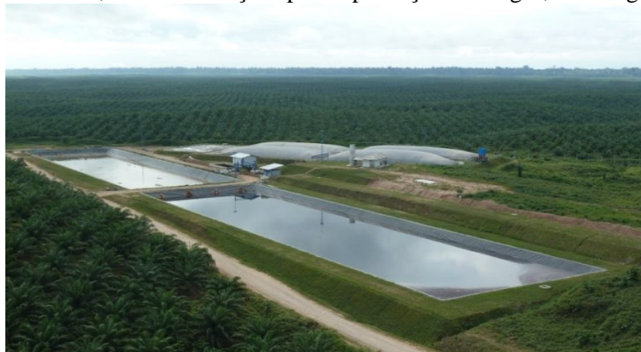
Fotografia 22- Sistemas de tratamento das águas residuais e recuperação para fertirriego na empresa Palmas de Shanusi, inclui instalações para a produção de biogás, Yurimaguas, Loreto Peru.
