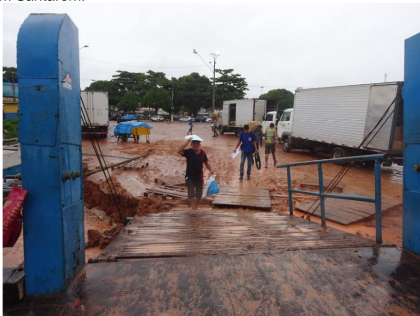
Fotografia 15 - Acesso portuário à balsa que atrelava a embarcação em Santarém.
