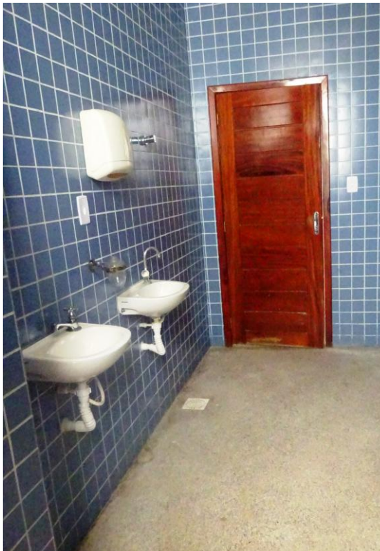
Fotografia 29 - Banheiro de uso público no terminal hidroviário de Oriximiná.
