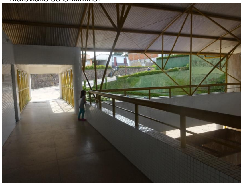
Fotografia 19 - Vista interna do segundo pavimento do terminal hidroviário de Oriximiná.
