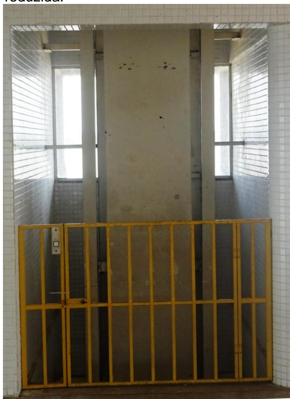
Fotografia 27 - Elevador de passageiros com mobilidade reduzida.
