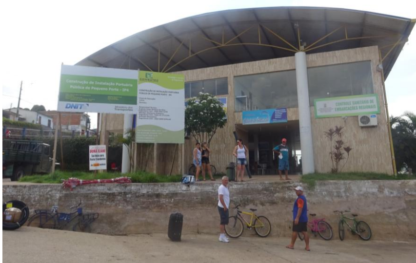
Fotografia 18 - Vista lateral ao rio do terminal hidroviário de Oriximiná.
