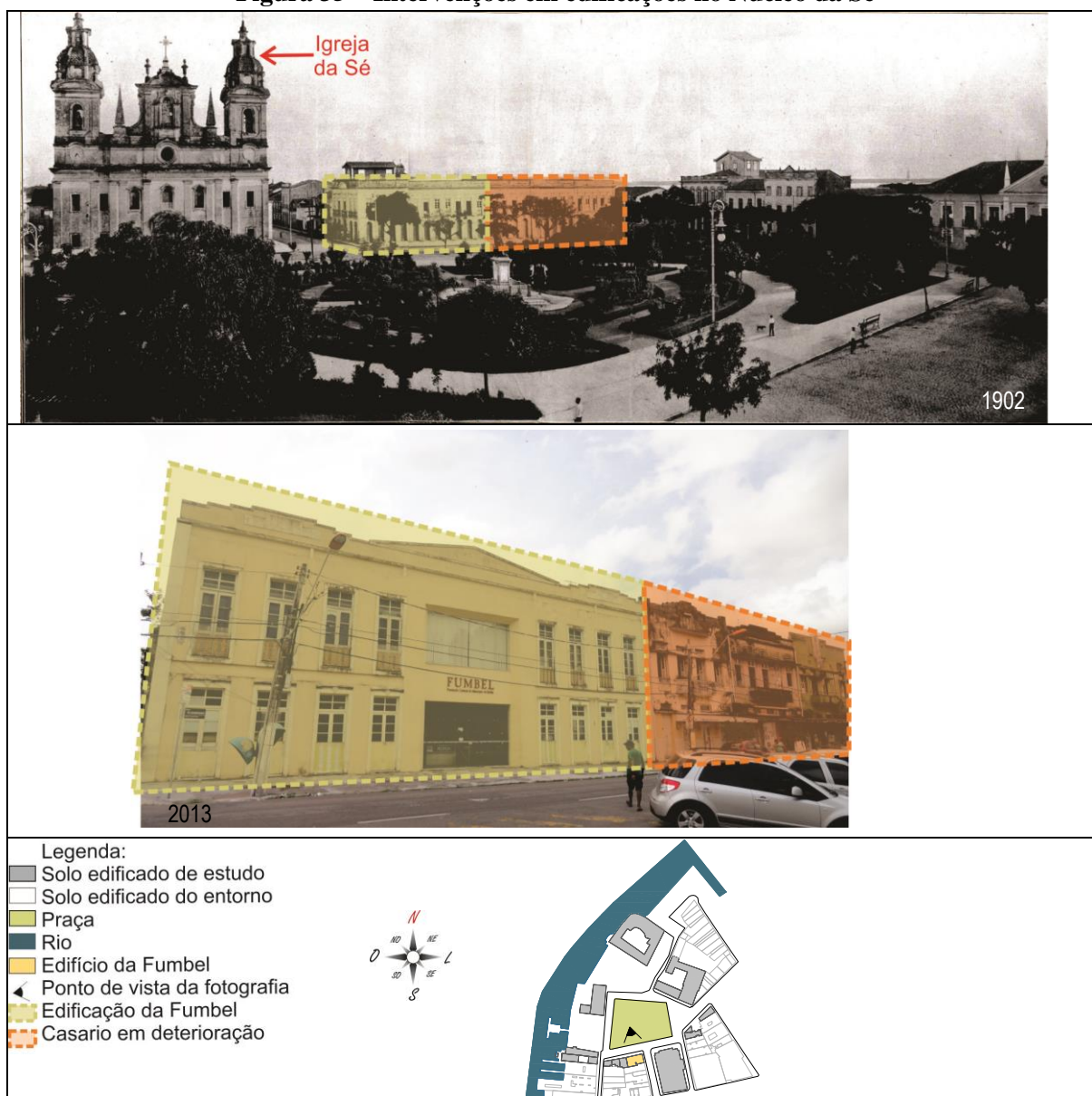
Figura 35 – Intervenções em edificações no Núcleo da Sé
