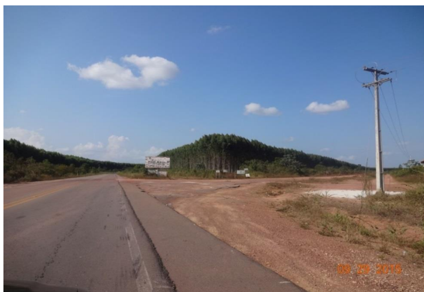
Fotografia 3- Ramal de acesso à São Pedro dos Bois/km 50.
