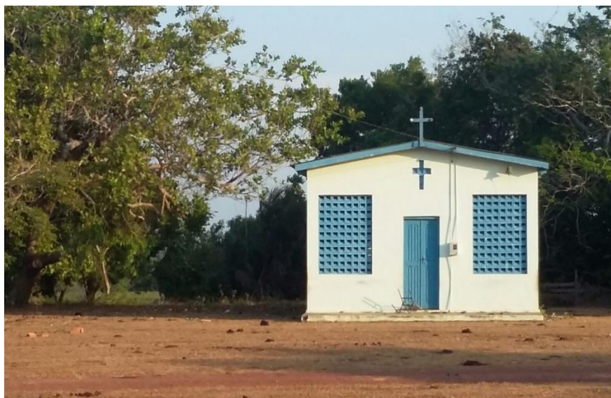
Fotografia 5 - Fotografia: Igreja Católica
