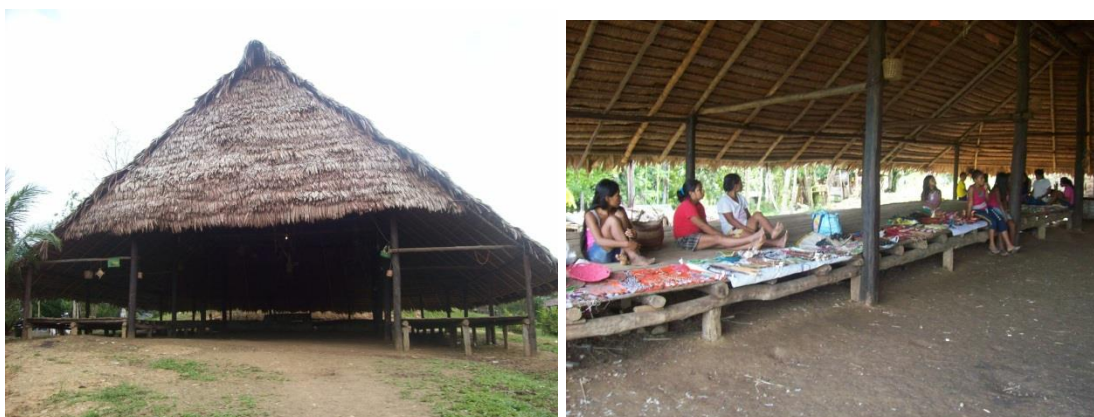
Fotografias 31 e 32- Aspectos externo e interno da maloca comunal
