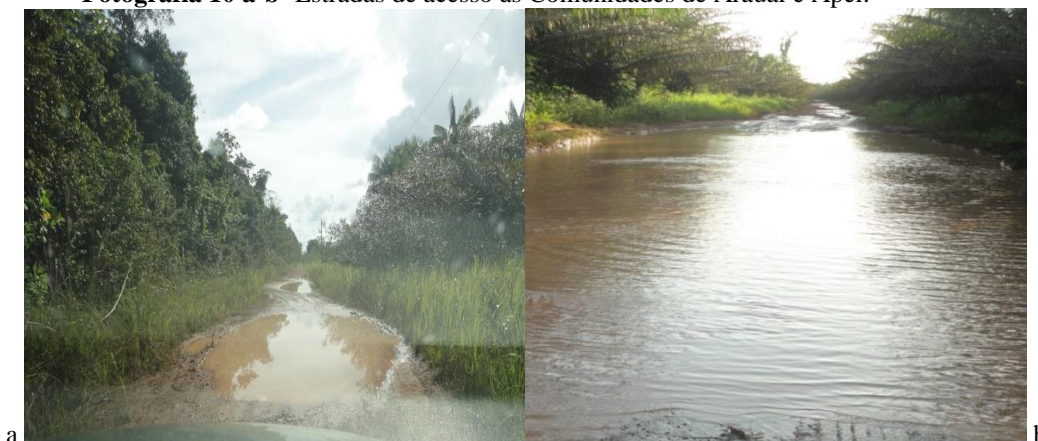
Fotografia 10 a-b- Estradas de acesso às Comunidades de Arauaí e Apei.
