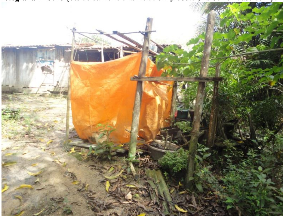
Fotografia 4- Condições do banheiro externo de um produtor, na Comunidade do Apei.
