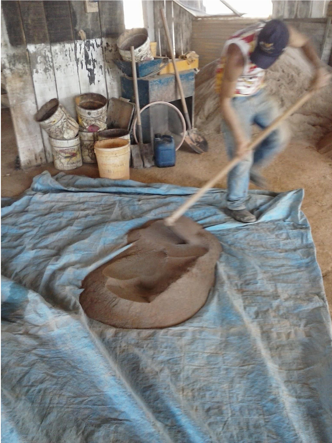
Figura 25 Homogeneização da mistura.
