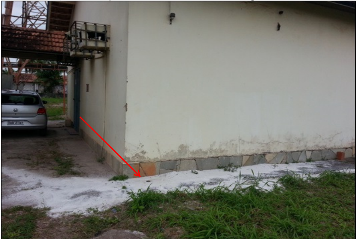
Figura 13 – Calçada na Qual se Encontra Cravada a Chapa da RN 840R
