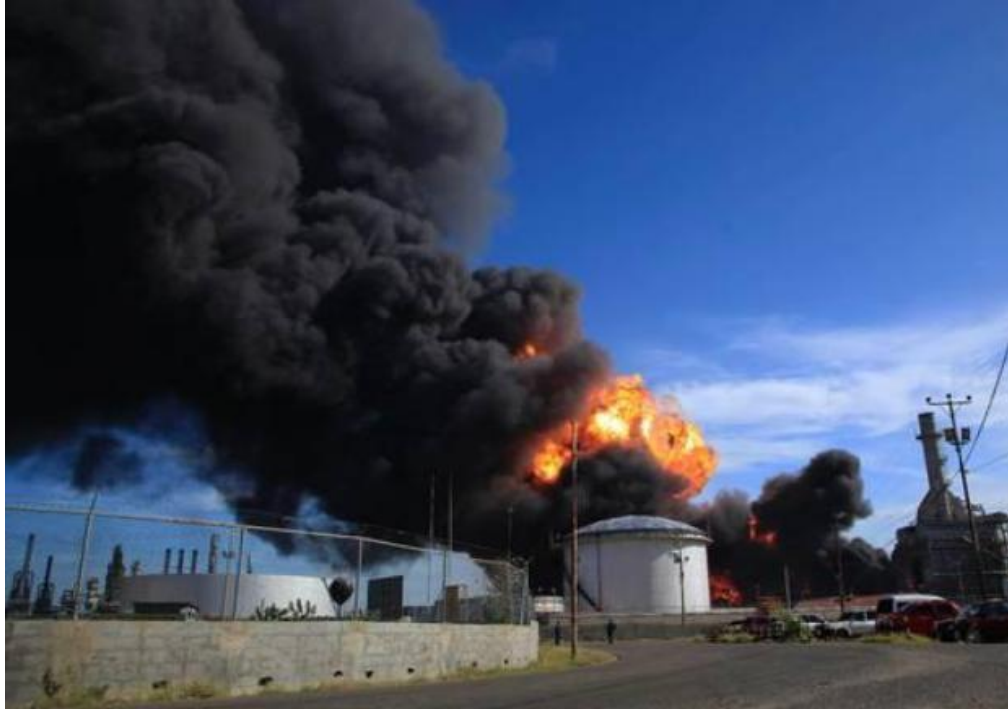
Figura 2. Raio provocou incêndio em usina em Ourinhos, no interior de São Paulo.
