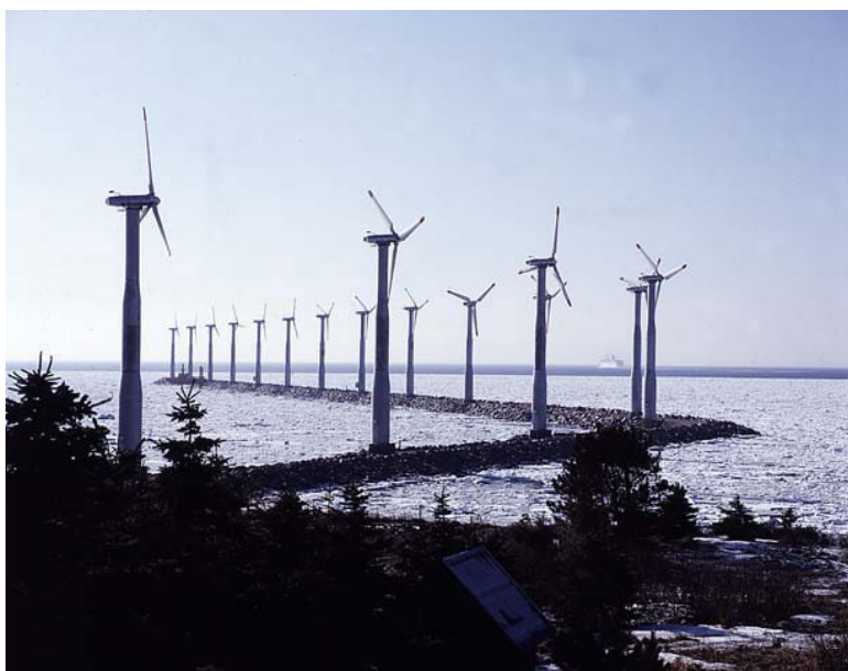
Figura 1.12 – Parque eólico com aerogeradores Nordtank de 55 kW (WINDPOWER, 2005).
