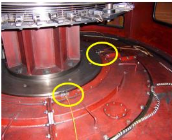
Figura 3.4 Sensor de proximidade ao lado do anel coletor.
