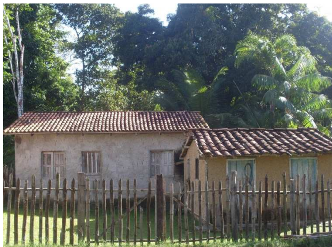
Figura 23 – Casa em alvenaria atrás da casa de barro na comunidade Açú
