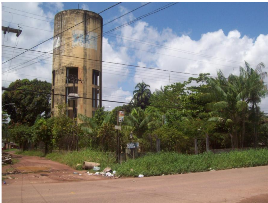
Fotografia 5 – Estação de captação, armazenamento e distribuição do SAAEB no bairro Brasília
