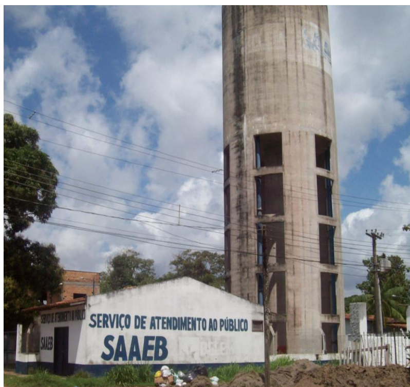
Fotografia 6 – Estação de captação, armazenamento e distribuição do SAAEB no bairro São João de Outeiro Fonte: Pesquisa de campo (2011)
