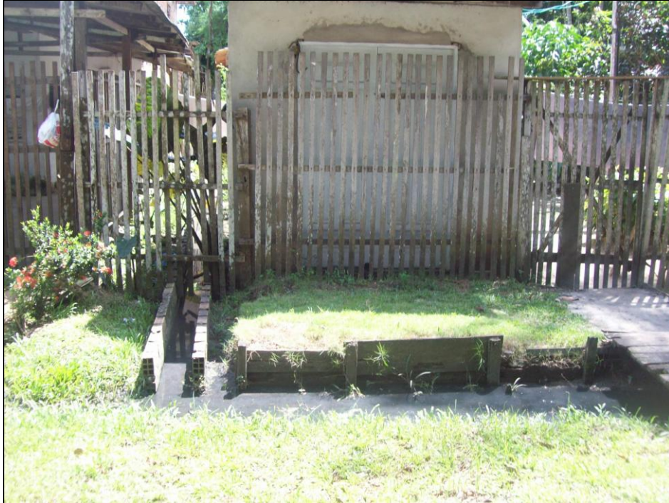
Fotografia 1 – Lançamento de águas residuárias a céu aberto, utilizando a drenagem, seguindo um fluxo linear controlado pelo gradiente topográfico Fonte: Pesquisa de campo (2012)
