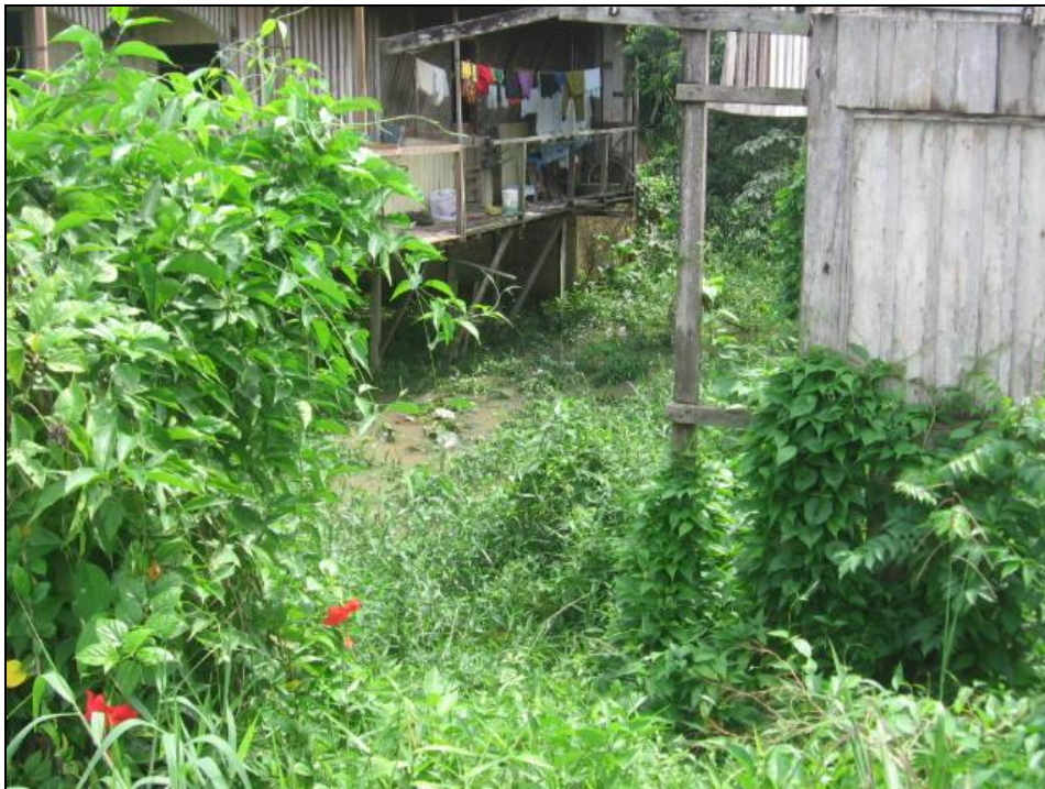
Fotografia 2 – Residência construída sobre o igarapé Água Boa, na ilha de Caratateua Fonte: Pesquisa de campo (2011)
