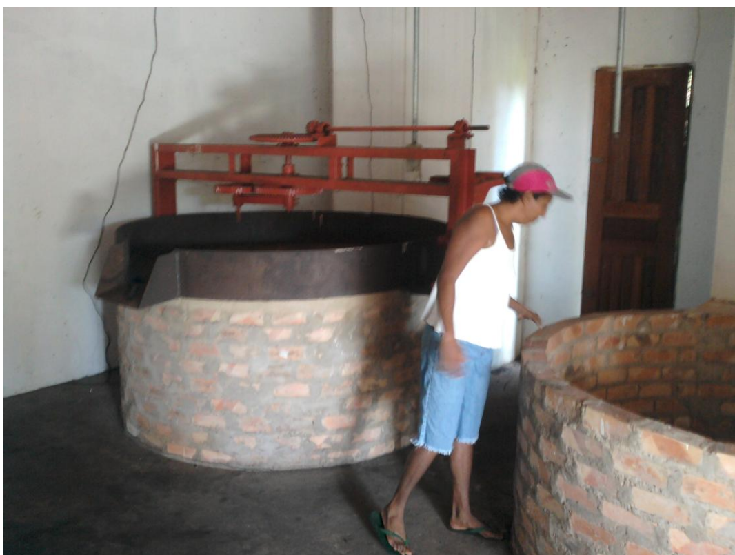
FOTO 15 - ESTRUTURA INACABADA DA NOVA CASA DE FARINHA: é possível ver cupins na parede ao fundo e a instalação elétrica inacabada. Foto: José Luiz Sirotheau (12/02/2012).
