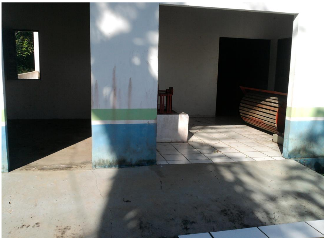
FOTO 14 - ESTRUTURA DA NOVA CASA DE FARINHA: dentro do prédio encontram-se vários maquinários próprios para a produção de farinha, mas que estão estragando pela ação do tempo. Foto: José Luiz Sirotheau (12/02/2012).
