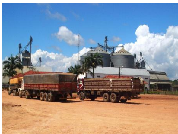
Fotografia 07 – Armazéns e secadores de grãos.
