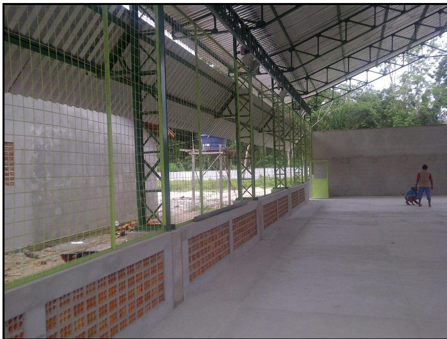
FOTO 09 - ESCOLA-POLO BOM FUTURO, MUNICÍPIO DE MOCAJUBA: localizada na comunidade de Tauarezinho, possui seis salas de aula e foi construída a partir da celebração do convênio 001/2010 entre ELETRONORTE e prefeitura de Mocajuba. Na ocasião da foto, a construção ainda estava em andamento. (Foto: ELETRONORTE, fevereiro de 2013).
