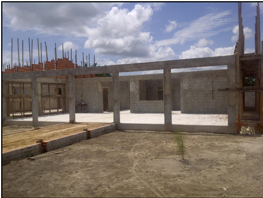
FOTO 10 - ESCOLA-POLO NA COMUNIDADE DE SANTA MARIA DO ICATÚ, MUNICÍPIO DE IGARAPÉ MIRI: possui oito salas de aula e quadra poliesportiva e foi construída a partir da celebração do convênio 003/2010 entre ELETRONORTE e prefeitura de Igarapé Miri. Na ocasião da foto, a construção ainda estava em andamento. (Foto: ELETRONORTE, fevereiro de 2013).
