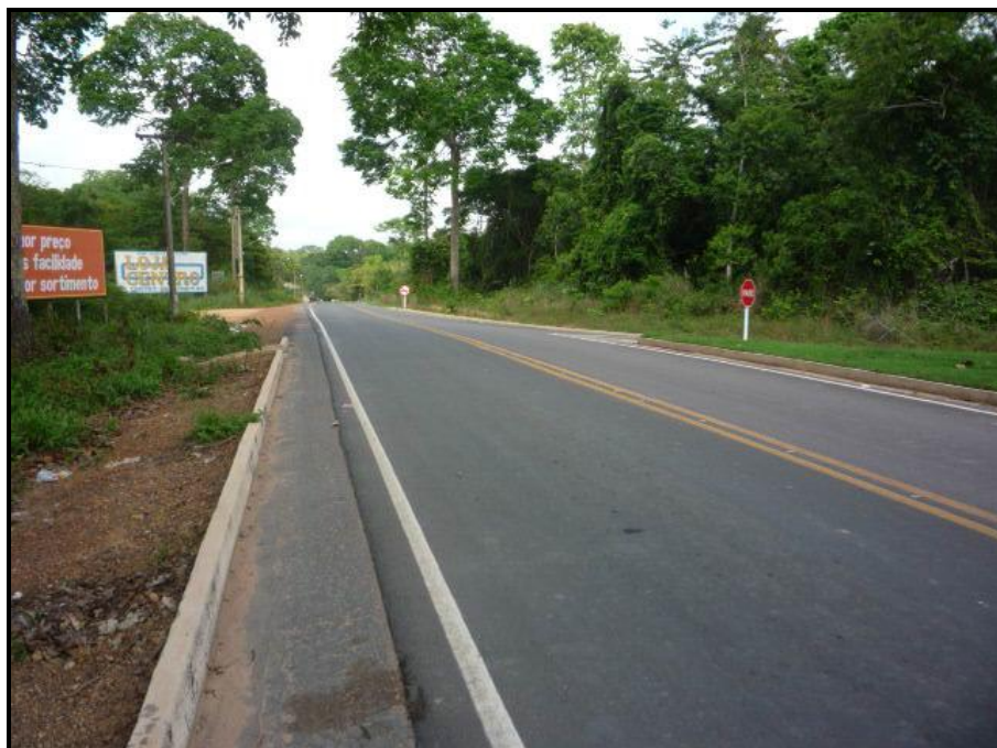
FOTO 03 – PA 151: trecho pavimentado da principal rodovia que liga o município de Baião ao município de Mocajuba. (Foto: Michel de Melo Lima, dezembro de 2010).
