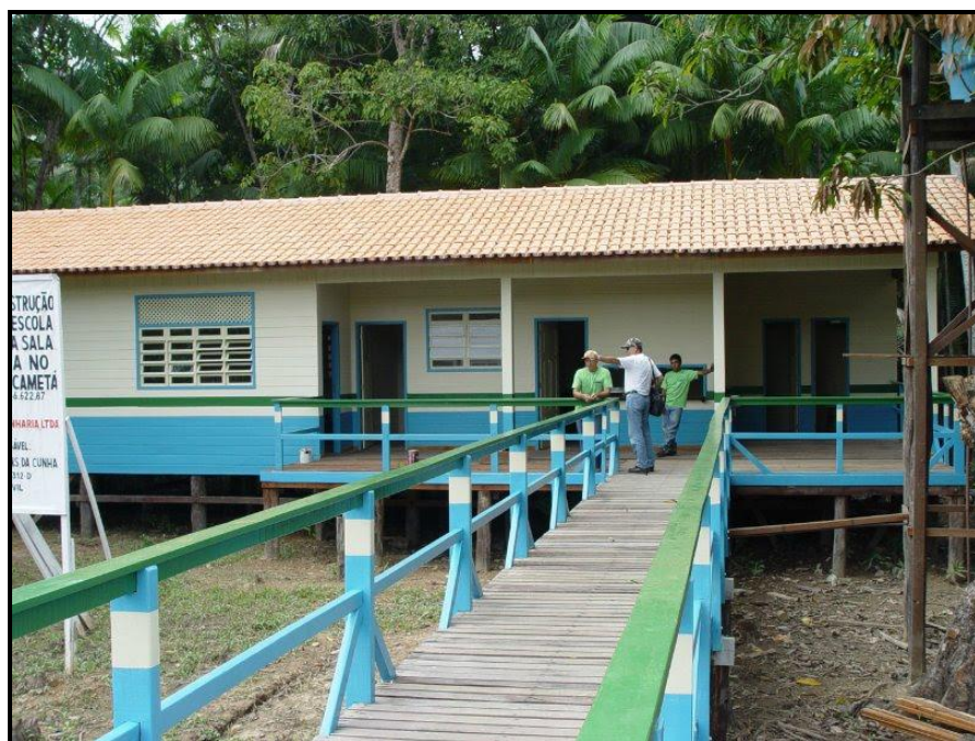
FOTO 04 – ESCOLA DA COMUNIDADE DE PRATICAIA, MUNICÍPIO DE CAMETÁ: uma das três escolas construídas com a celebração do convênio 022/2004 entre ELETRONORTE e prefeitura de Cametá, em madeira e com uma sala de aula. (Foto: ELETRONORTE, dezembro de 2006).
