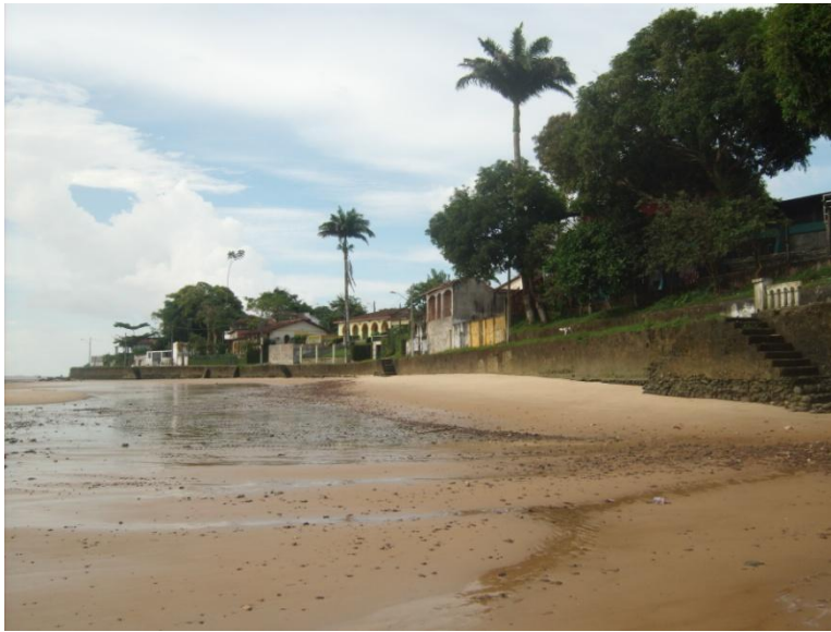
Foto 15: Geofácies Ie: muros de arrimo e pistas asfaltadas garantem a estabilidade física ao longo da linha de costa. Ao fundo, residências de classe média, jardins e quintais parcialmente arborizados, próximos à linha de costa. Em primeiro plano, praia do Areião com areias médias a grossas e cascalhos, expostos durante a maré baixa. A orla urbanizada interfere na fisiologia do Geofácies. Ao mesmo tempo que protege as falésias da ação das ondas e da erosão, reduz o suprimento sedimentar para a praia, favorecendo sua característica erosiva, além de promover o lançamento de efluentes (Foto: Ivan Viana, maio/2013).
