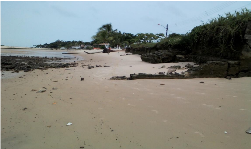
Foto 9: Em primeiro plano observa-se o banco de cascalho e o muro de arrimo destruído pelos processos erosionais. Ao fundo, palmeiras que foram também afetadas por tais processos (Foto: Ivan Viana, Maio/2011)
