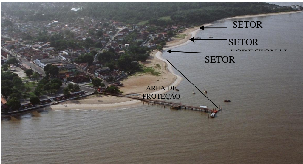
Foto 7: Área de proteção gerada pelo trapiche. A jusante desta área, percebe-se o setor erosional, indicado pela reentrância praial acentuadamente côncava, sucedido por um setor deposicional caracterizado pela geometria convexizada (Foto: Projeto Orla, 2006).
