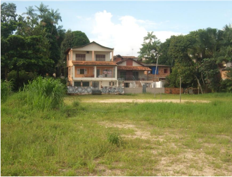
Foto 24: Geofácies IIa3: Ocupação residencial da zona de pós-praia (Foto: Ivan Viana, maio/2013).
