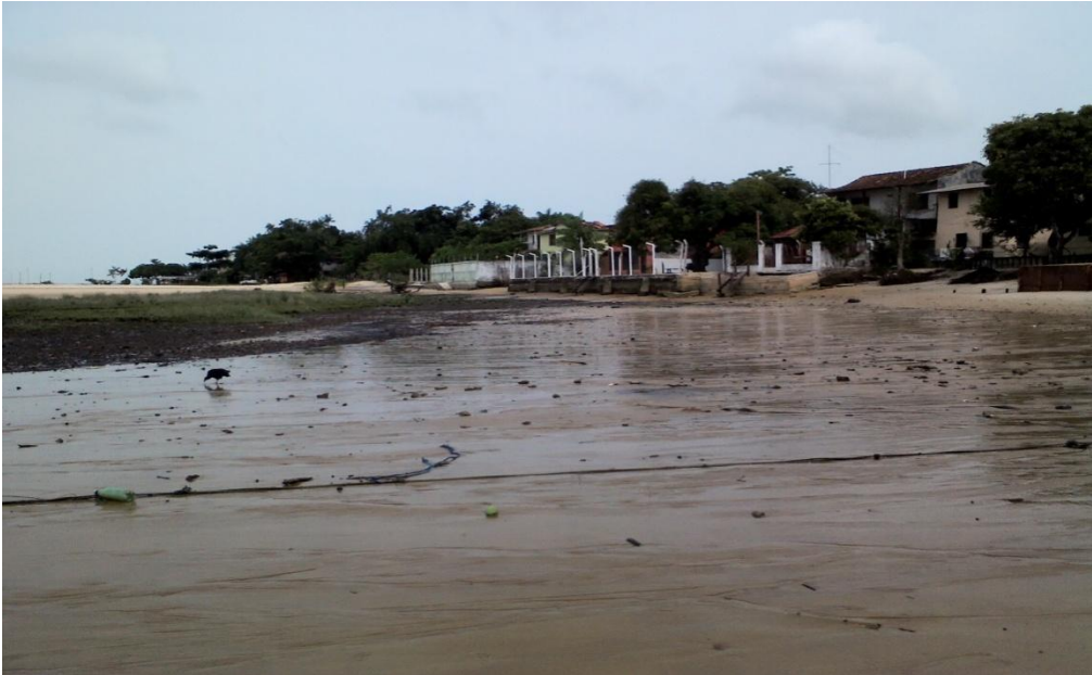
Foto 8: No lado esquerdo da fotografia observa-se o banco de cascalho característico dos setores erosionais. Ao fundo notam-se obras de proteção contra a erosão nas residências localizadas sobre a falésia e pós-praia (Foto: Ivan Viana, Maio/2011)
