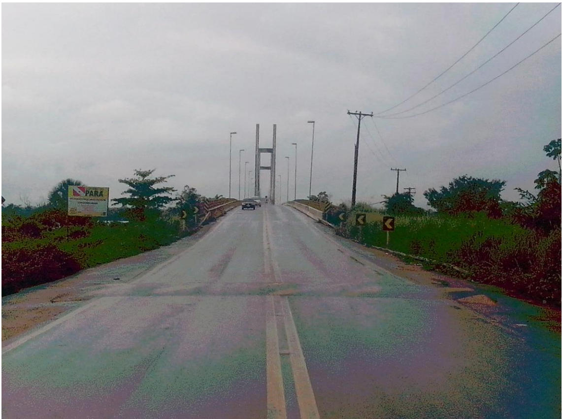
Figura 8: Ponte sobre o Rio Guamá, Pa 151, Km 11, 05/03/2014 (créditos do autor)
