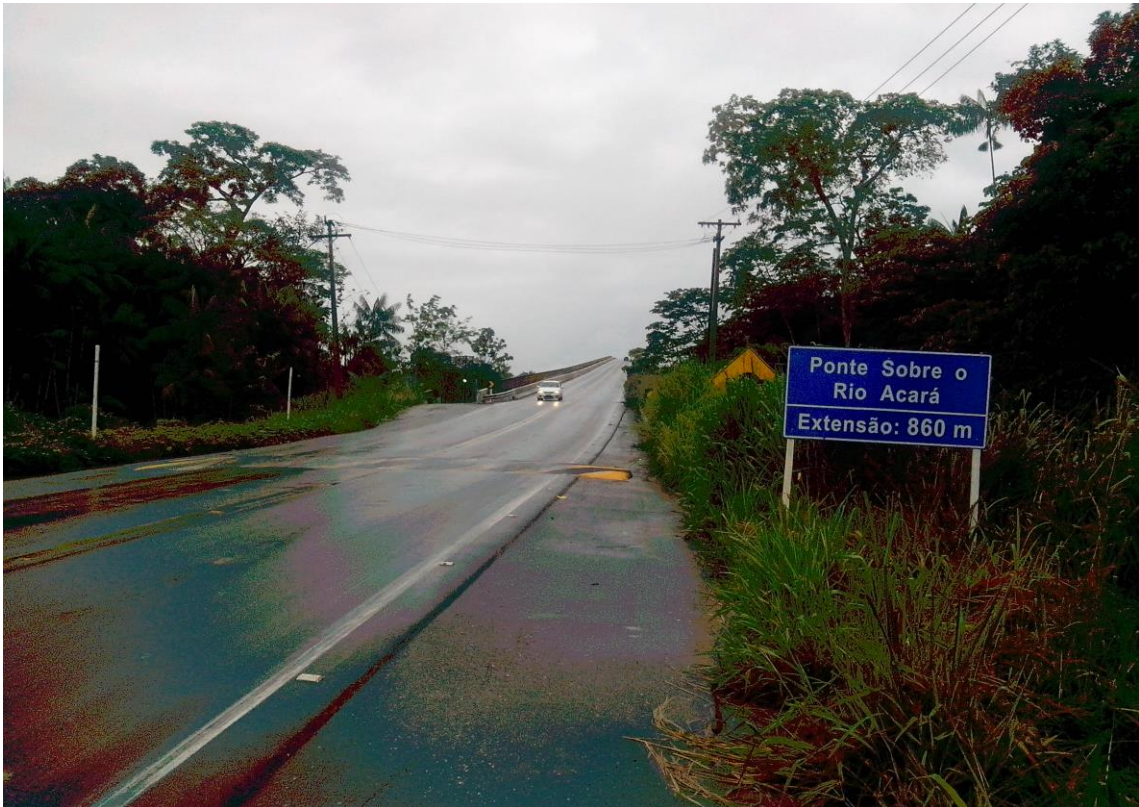
Figura 10: Ponte sobre o Rio Acará, Pa 151, Km , 05/03/2014 (créditos do autor)
