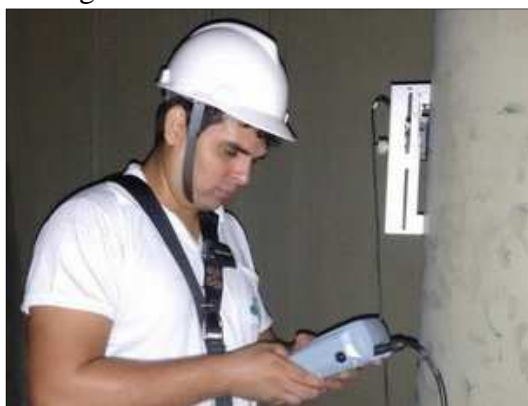
Fotografia 15: vazão no bombeamento.
