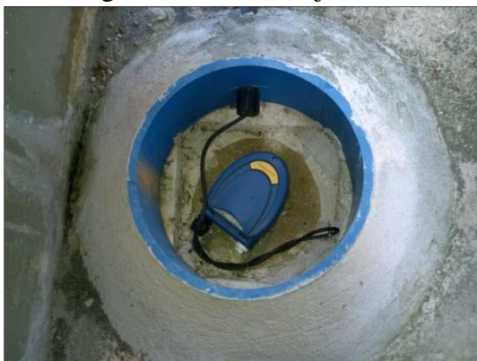
Fotografia 18: N1 na laje do RAP.
