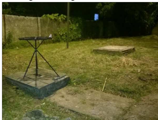
Fotografia 2: registro da subadutora.
