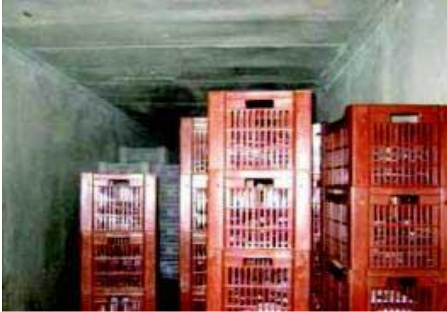
Figura 22: Câmara fria para estocagem do açaí. Fonte: Ben Hur (s/d)
