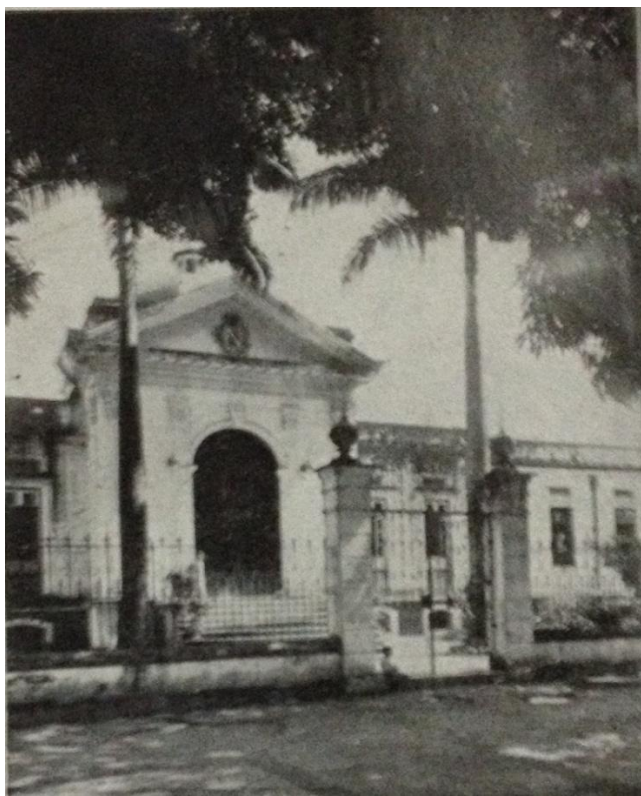
Imagem 6 – Vista geral do edifício do Hospício dos Alienados (1922)
