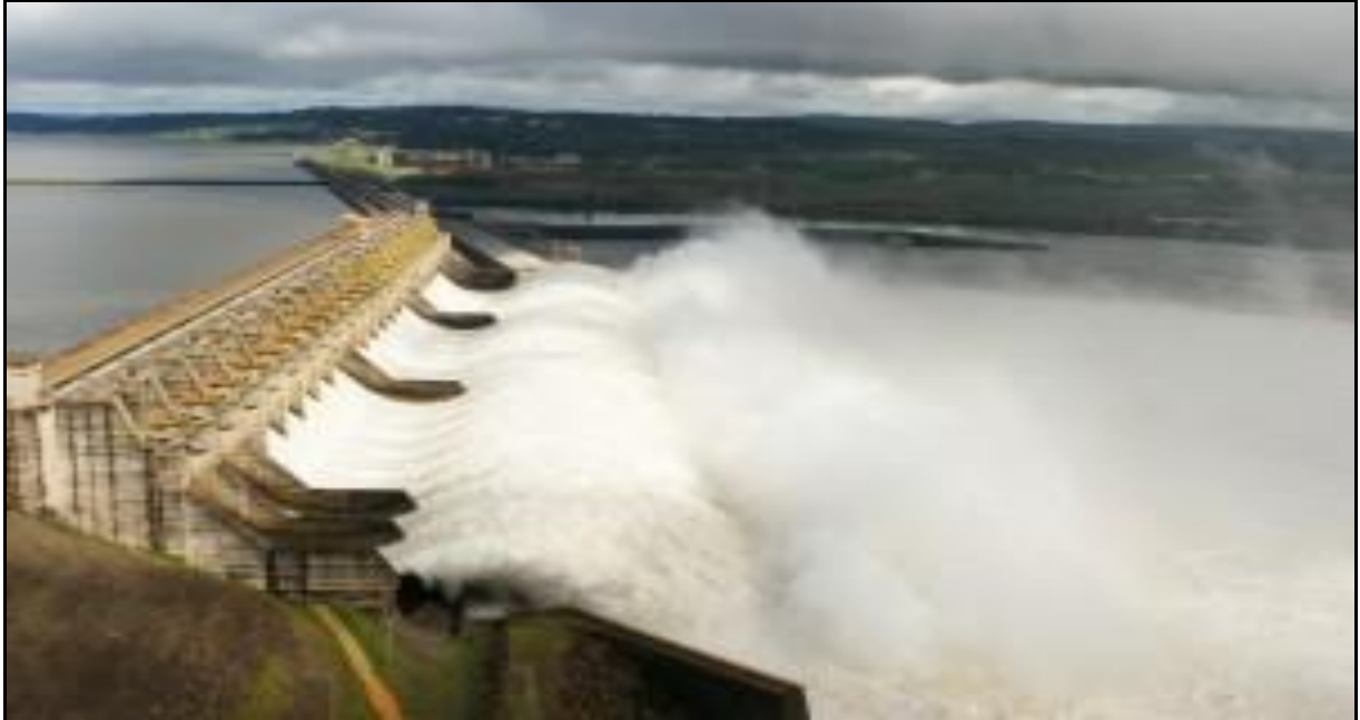
FOTO 02. Usina Hidrelétrica de Tucuruí com vertedouros abertos.
