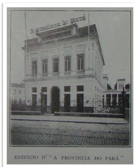
FIGURA 1 - Álbum de 1908 - Edifício da Província do Pará
