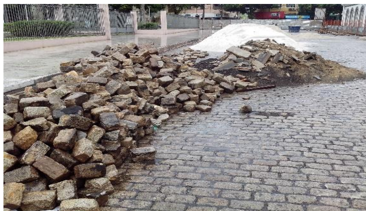
Imagem 102 - Paralelepípedos após a retirada das camadas de asfalto Fonte Jeová Barros (2015).
