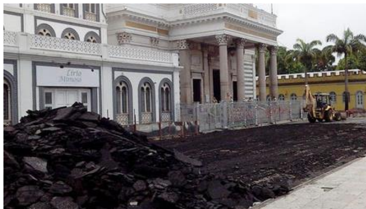
Imagem 100 - Obras para transformação da rua da Basílica em calçada Fonte Jeová Barros (2015).
