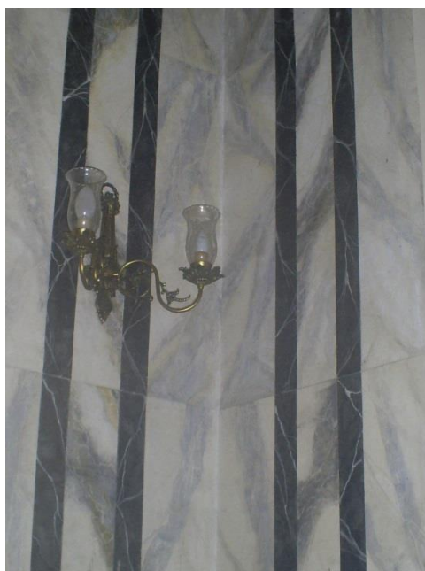
Imagem 142 PINTURA MARMORIZADA NAS PAREDES DA CAPELA DO PADRE AFONSO Fonte: Jeová Barros, 2013
