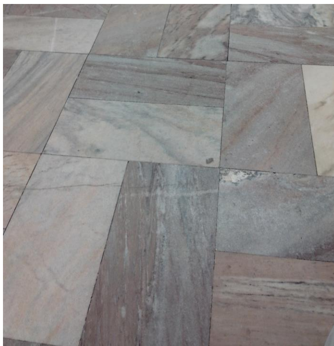
Imagem 138 MÁRMORE EM PADRÃO CHOCOLATE QUE COMPÕE O PISO DA NOVA CALÇADA Fonte: Jeová Barros, 2015
