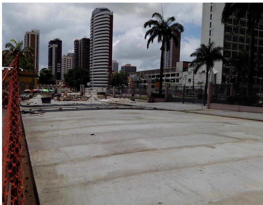
Imagem 136 CONTRAPISO SOBRE PARALELEPÍDOS NA RUA DA BASÍLICA QUE ESTÁ SENDO REFORMADA COMO CALÇADA Fonte: Jeová Barros, 2015
