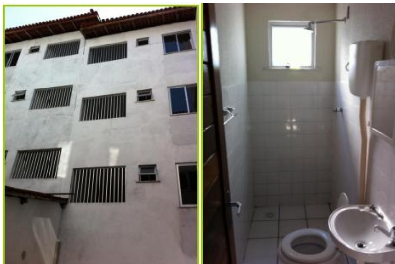
Ilustração 22 - Fotos do Residencial Cabano (finalização das obras) no PER de 2011. Fonte: Belém 2011.
