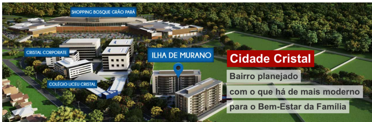
Figura 18 – Empreendimento proposto pela construtora local para a área adquirida da Marinha próxima ao Aeroporto de Val-de-Cans (obras já sendo executadas)
