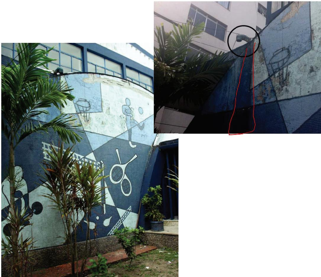
Figura 190 – Observar as lacunas, as manchas de umidades e no detalhe as lacunas, a inserção de dutos de quedas de água (obsrvar a mancha escura na trajetória da água expelida pelo duto)
