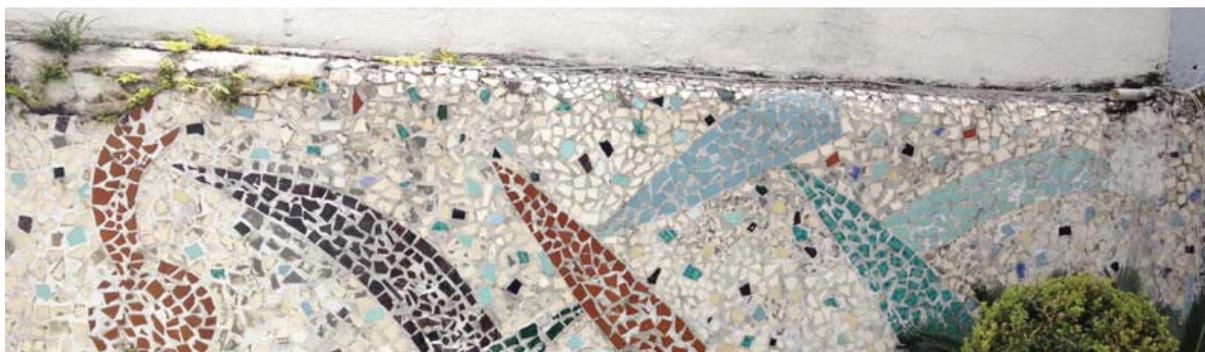
Figura 181 – Painel em caco de azulejo em edifício da Avenida Nazaré. Presença de vegetais superiores e inserção de tubulação.
