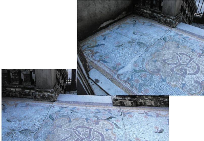
Figura 156 – Mosaico do patamar da escada externa do Palacete Bibi Costa: seções de descontinuidade como se o mosaico tivesse sido recolocado.
