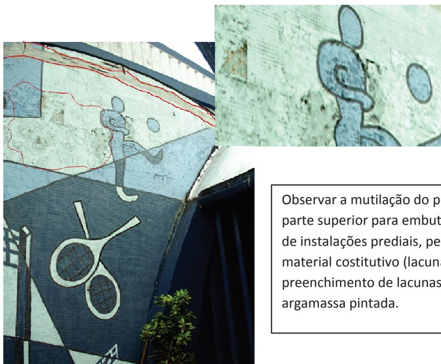
Observar a mutilação do painel na parte superior para embutimento de instalações prediais, perdas de material constitutivo (lacunas), preenchimento de lacunas com argamassa pintada.
