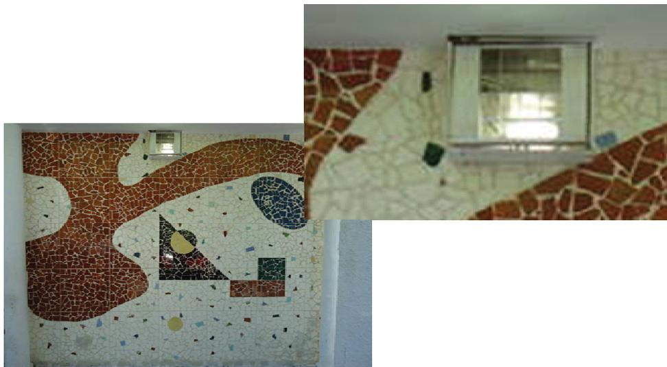
Figura 185 – Painel em caco de azulejo em edifício da Travessa Benjamin Constant. Mutilação do painel para a colocação de exaustor.
