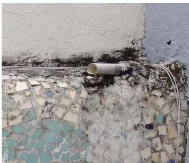
Figura 182 – Detalhe do painel em caco de azulejo em edifício da Avenida Nazaré. Detalhe do buzinote para escoamento da água.
