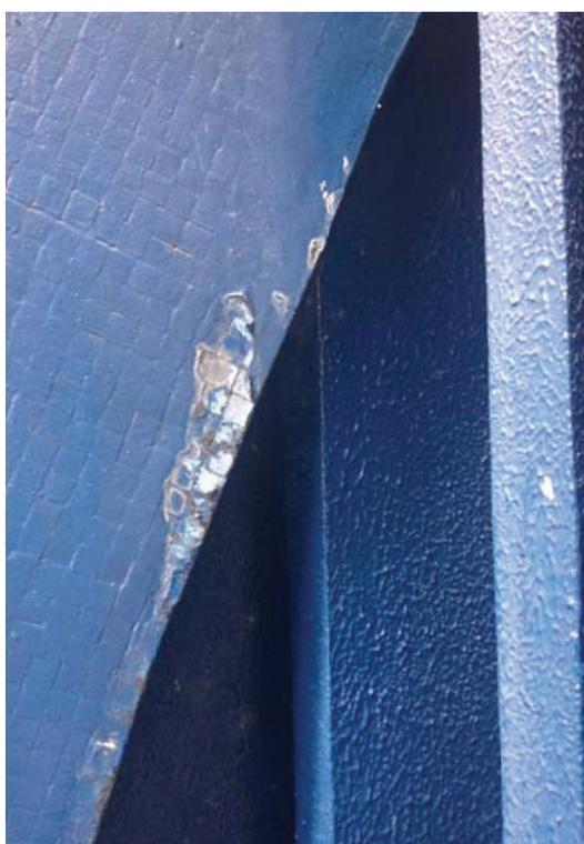
Figura 193 – Aplicação de tinta sobre as pastilhas
