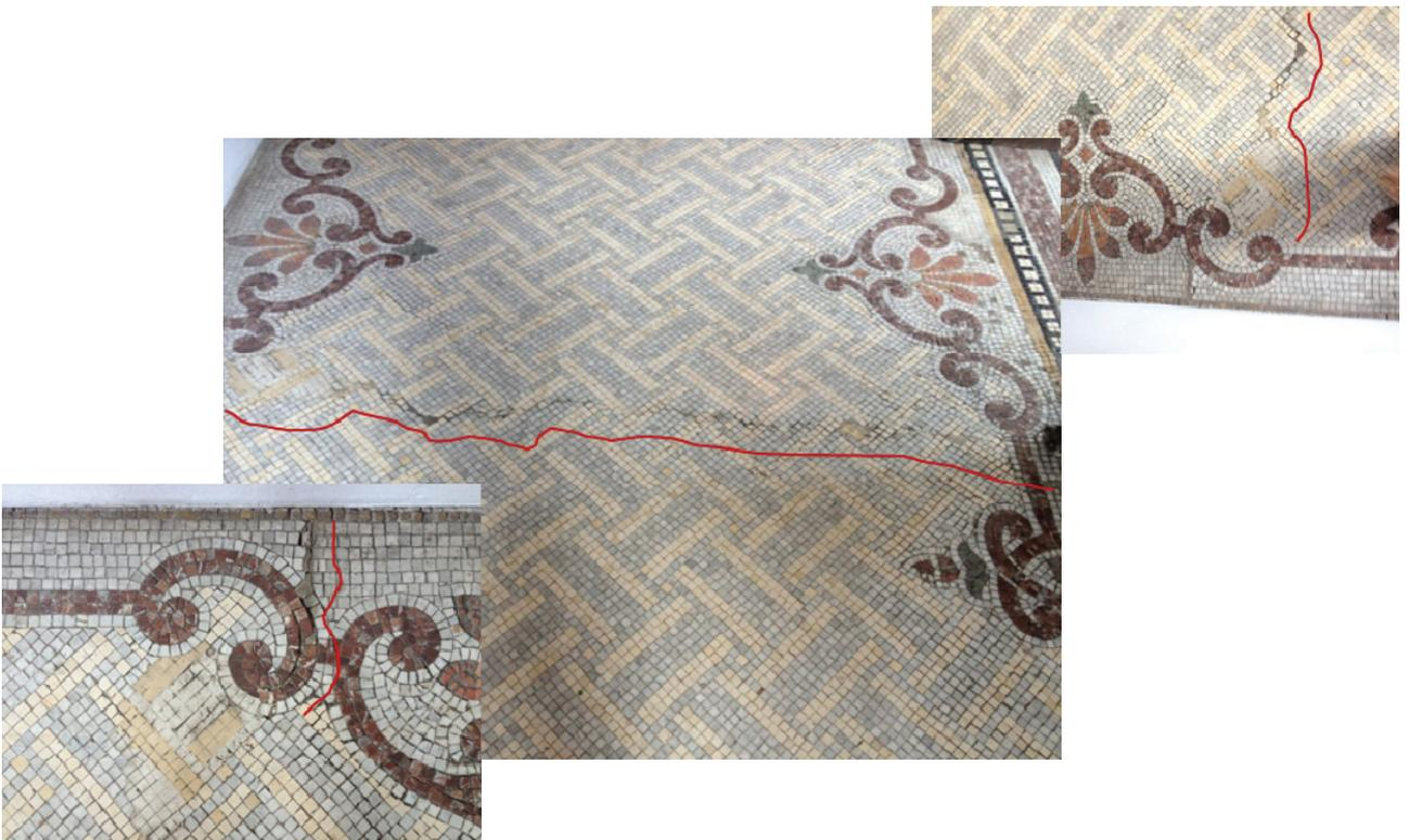
Figura 162 - Palacete Augusto Montenegro: fissura geral e em detalhe.
