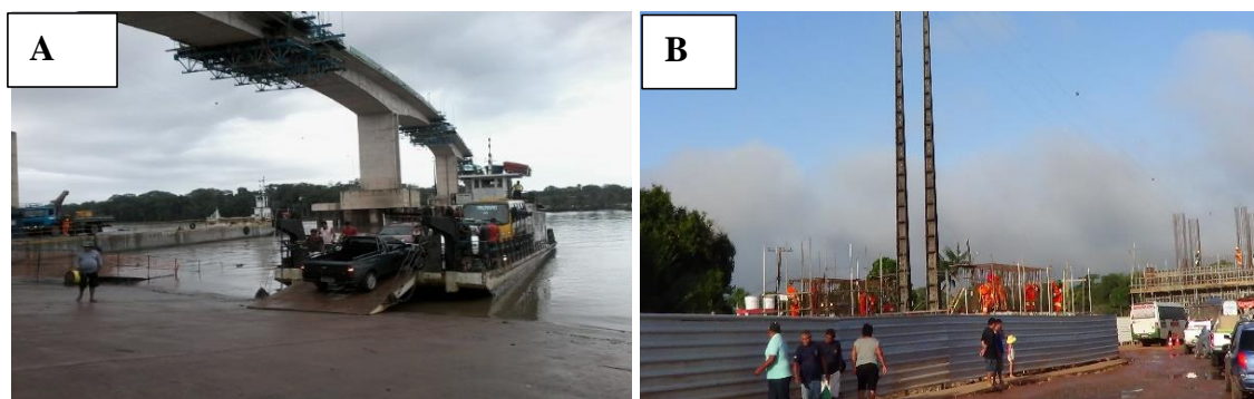
Figura 13. Construção da ponte do rio Matapi no período de 2013 (A) a 2015 (B) que dá acesso por via terrestre ao assentamento agroextrativista do Anauerapucu.
