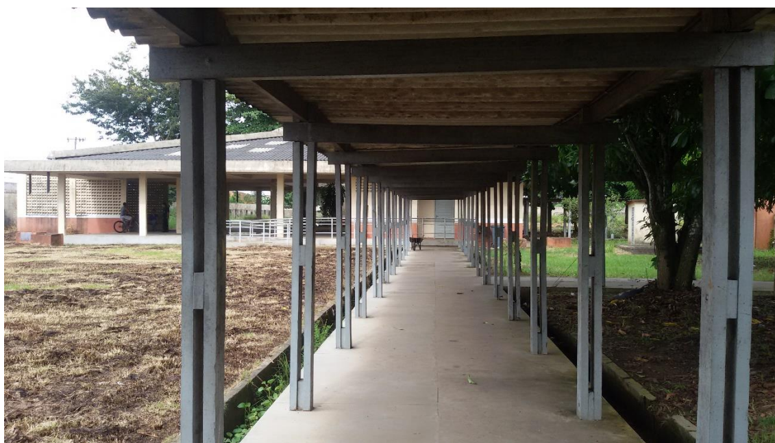
Figura 10 – Passarela de acesso as salas de aula.
