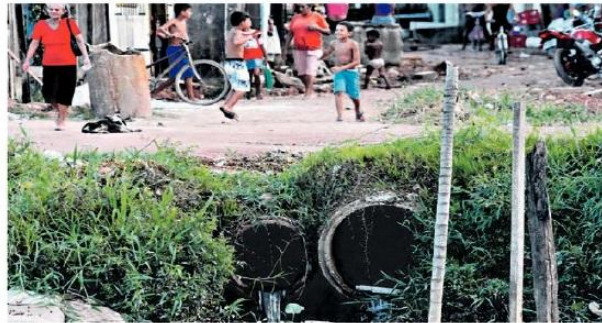
Segundo dados do IBGE, 33,3% dos domicílios do município de Belém estão próximos de algum ponto de esgoto a céu aberto
