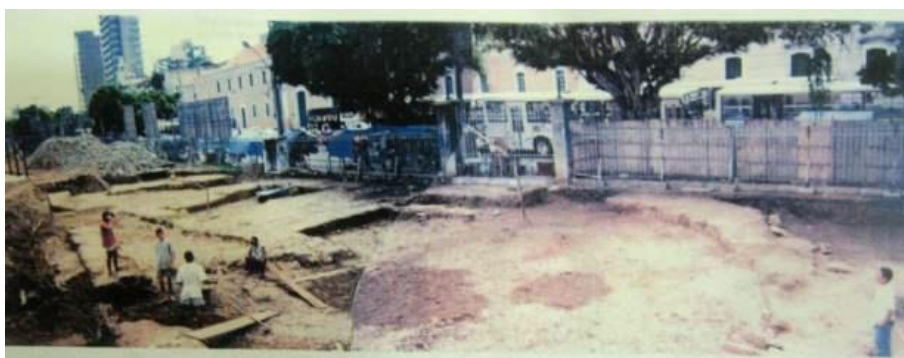
Figura 23: Vista Geral da área escavada, destacando trechos interrompidos do paredão do antigo Cais da cidade, a situação do piso do pátio, alicerces de um dos ambientes internos, e da muralha externa do Forte São Pedro Nolasco. Fonte: Relatório de Prospecção do Cais do Porto de Belém (1999a).
