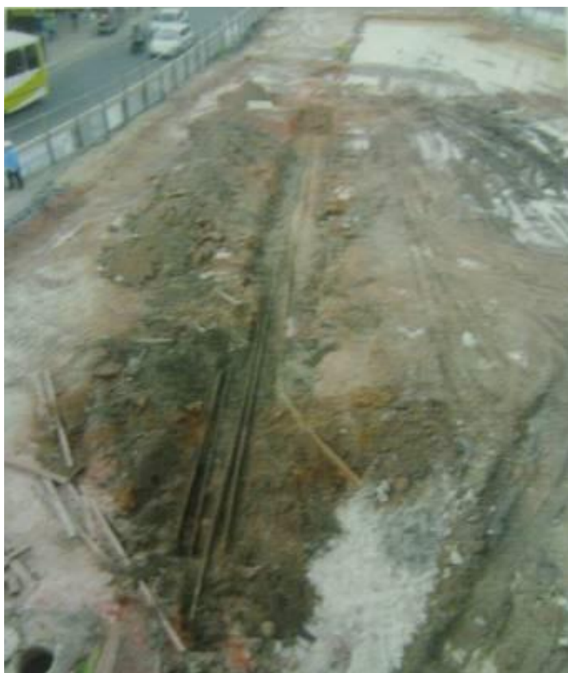
Figura 33: Vista Geral da disposição dos trilhos na escavação. Fonte: Relatório de Acompanhamento 8/IPHAN (2013).
