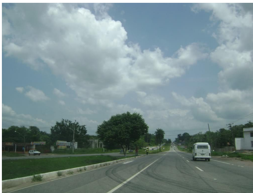
Foto 02: Entrada (Boca) de Benfica
