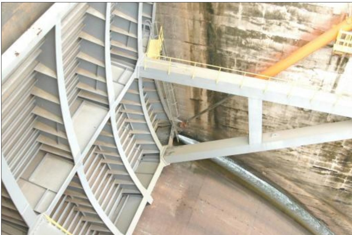
Figura 6 – Comporta do vertedouro, a maior do mundo
