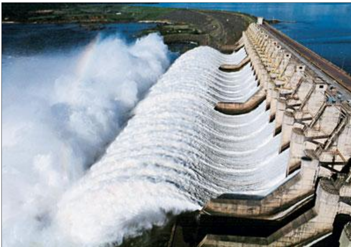
Figura 9 – Vazão do vertedouro
