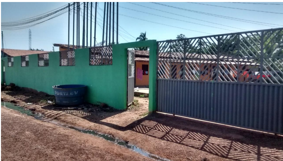
IMAGEM 14- Vila de kitnets construídos na Vila Forquilha.
