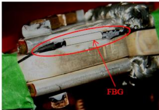
Figura 7.2 - Sensor FBG instalado em uma conexão polar.
