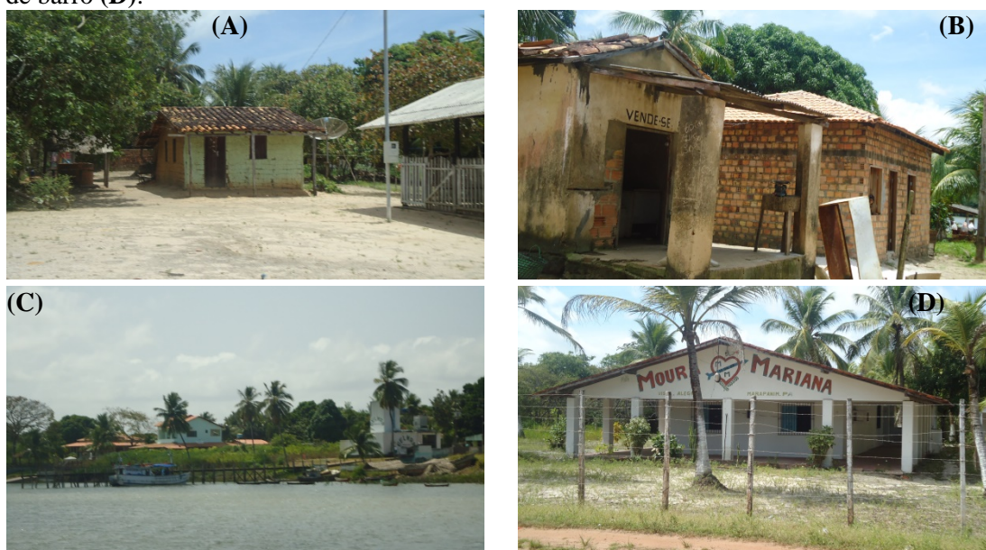
Figura 9: Fotos (A), (B), (C), (D) – Casa de taipa com enchimento de barro (A) com telha de barro. Casa de alvenaria (B). Casa de luxo com rampa de concreto armado de propriedade do Deputado Estadual Márcio Miranda (C). Casa de padrão misto (madeira e cimento) com telha de barro (D).
