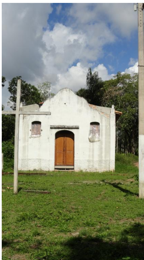
Fotografia 3 - A Igreja São Sebastião construída pelos quilombolas de Burajuba, após o retorno.
