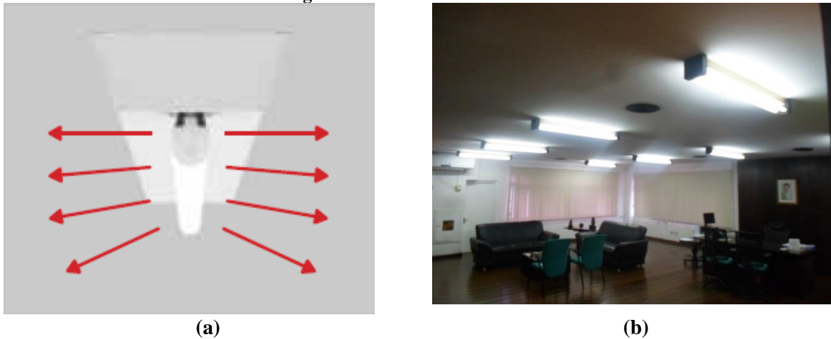
Figura 5.7 – Luminárias Ineficientes
