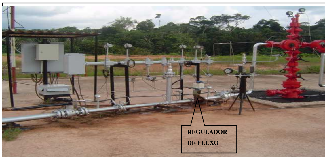
Figura 4.1 Instrumentação instalada na Cabeça dos Poços do Campo de LUC (UNBSOL).
