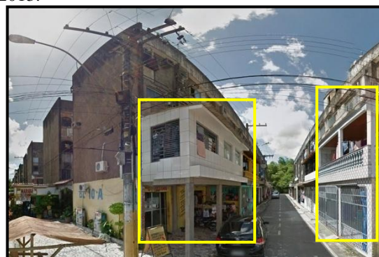
Foto 26. CONSTRUÇÃO DE “PUXADINHO” NO CONJUNTO IMPÉRIO AMAZÔNICO (Belém. BNH). Nota-se a construção anexa improvisada, conhecida localmente como “puxadinho”, avançando sobre as já reduzidas calçadas, além do uso comercial no térreo. Fonte: Trabalho de Campo, 2013.
