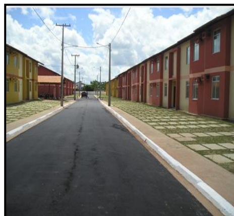
Foto 14. CONJUNTO MARIA LAISE (Castanhal). Outro exemplo de tipologia vertical produzida pelo PAR. Trata-se de um conjunto de 2 pavimentos, de padrão que vem se repetindo do período do BNH até o PMCMV. Fonte: www.atanengenharia.com.br
