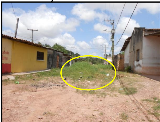
Foto 27. RUA OBSTRUÍDA NO CONJUNTO TAUARÍ. (Ananindeua, PAIH). A rua sem pavimentação e completamente interdita simboliza a infra-estrutura precária que marca boa parte dos conjuntos do PAIH, ocupados antes do término das obras. Fonte: Trabalho de Campo, 2013.
