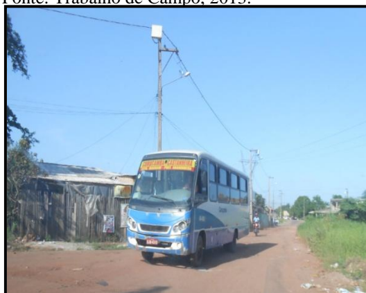
Foto 32. CONDIÇÕES DA VIA DE ACESSO AO CONJUNTO RORAIMA-AMAPÁ. (Ananindeua, HABITAR-BRASIL). Além de estreita, a via encontra-se com pavimentação comprometida e sem calçadas laterais. Do lado esquerdo, a residência avança sobre a via e do lado direito a presença de mato e lixo. Fonte: Trabalho de Campo, 2013.
