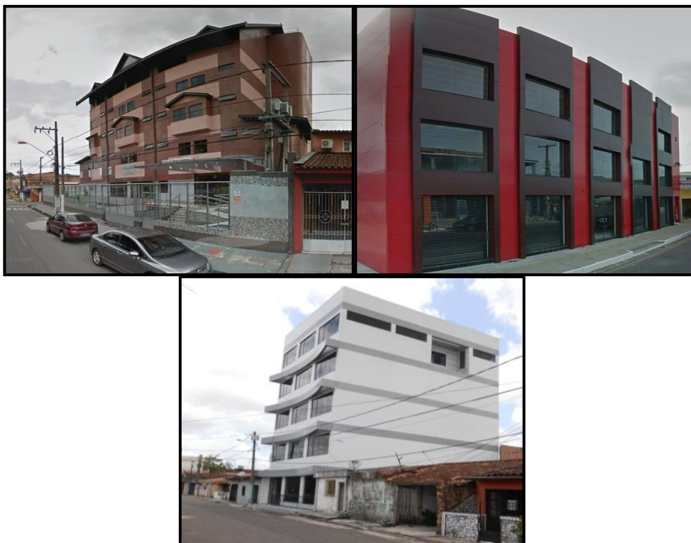
Fotos 41, 42 e 43. EDIFÍCIOS COMERCIAIS NOS CONJUNTOS NOVA MARAMBAIA, CIDADE NOVA E ABELARDO CONDURÚ (Belém e Ananindeua, BNH). A apropriação das diferentes rendas da terra assume destaque pelos promotores desses estabelecimentos. Trata-se de edifícios comerciais sofisticados, com salas reservadas para aluguel. Fonte: Trabalho de Campo, 2013.
