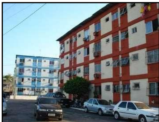
Foto 9. CONJUNTO NATÁLIA LINS (Belém). Tipologia vertical da transição pós - BNH. Conjuntos verticais de 4 pavimentos financiados pela CEF assumem destaque nesse período. Fonte: Trabalho de Campo, 2013.
