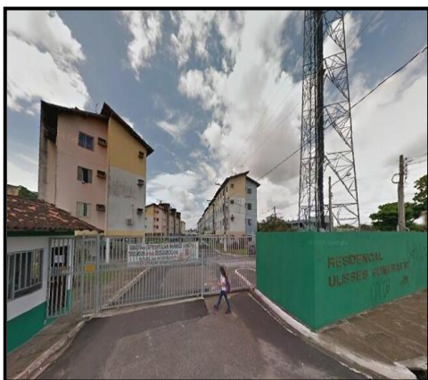
Foto 13. CONJUNTO ULISSES GUIMARÃES (Belém). Tipologia vertical produzida pelo PROCRED, destinada a funcionários públicos com renda entre 6 e 20 salários mínimos. Fonte: Trabalho de Campo, 2013.
