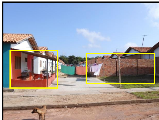
Foto 22. MODIFICAÇÕES NA ÁREA DOS FUNDOS DO CONJUNTO JARDIM DAS JURUTIS (Benevides. PMCMV). Nota-se que apesar de recente, o conjunto já mostra a ação intensa dos moradores, modificando de diferentes modos os quintais. Fonte: Trabalho de Campo, 2013.
