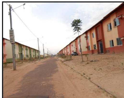
Foto 18. CONJUNTO PARQUE DOS IPÊS (Castanhal). Trata-se novamente da tipologia vertical de dois pavimentos. Esse conjunto do PMCMV também é composto por casas. Fonte: Trabalho de Campo, 2013.
