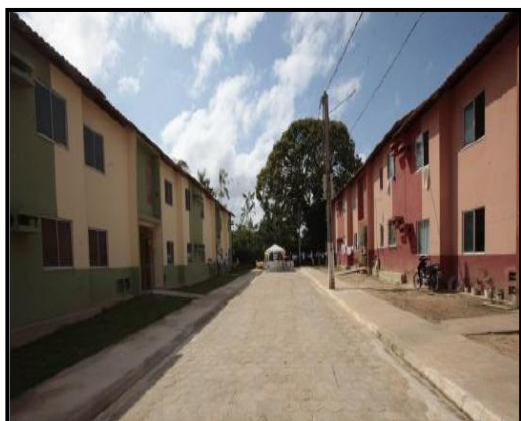
Foto 19. COMUNIDADE TABOQUINHA (Belém). Tipologia vertical de dois pavimentos do PAC, padrão que vem se repetindo fortemente na área de estudo. É válido ressaltar, porém, que a comunidade Taboquinha é composta, também por casas. Fonte: www.agenciapara.com.br
