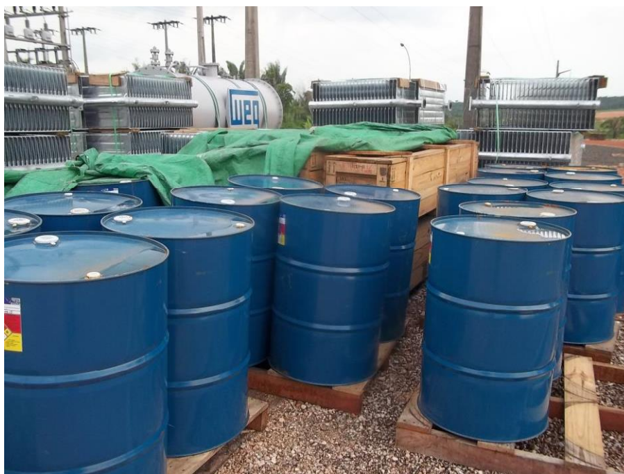
Figura 18 – Óleo mineral isolante em tambores de 200 litros.
